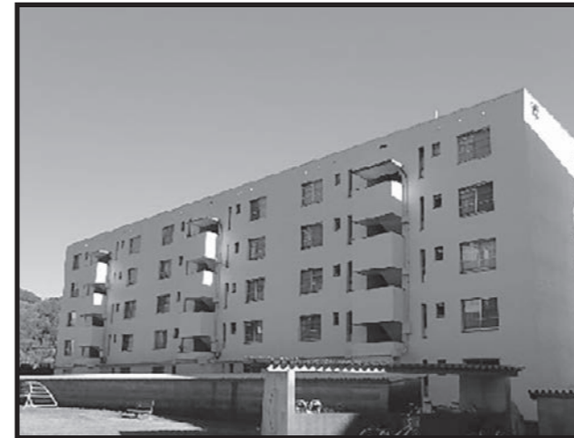
参考写真：県営麻機羽高団地15棟
