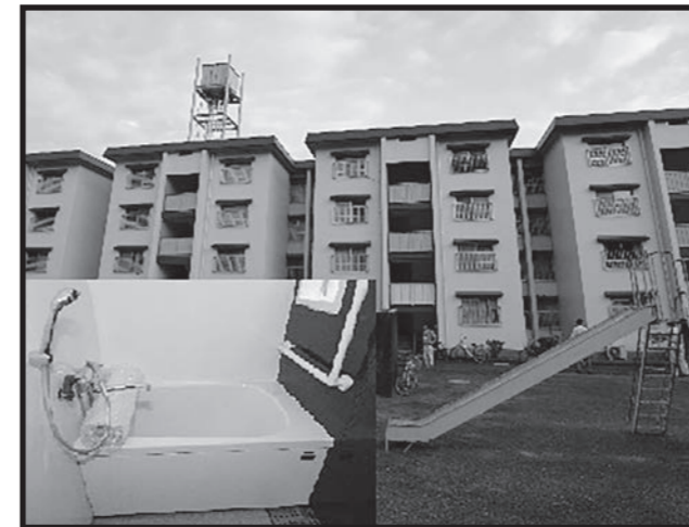
参考写真：県営麻機羽高団地24棟
