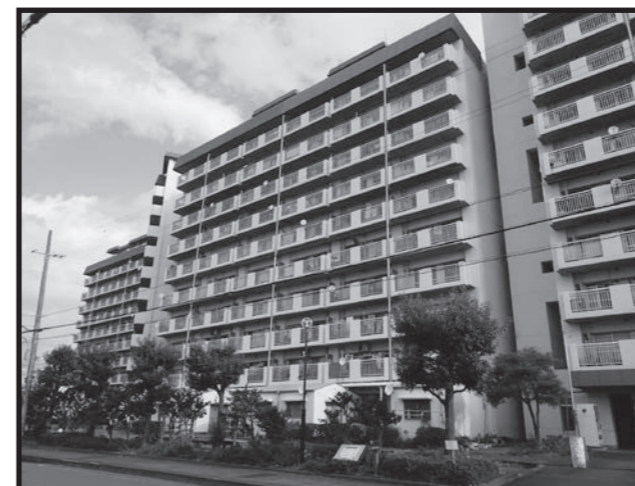
参考写真：県営有明団地3棟
