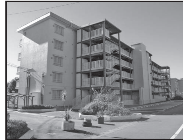
参考写真：県営興津団地5棟
