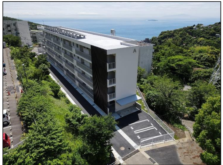
建物全景写真
